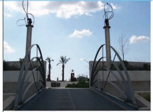
L'ingresso alla "Rotonda" attraverso il ponte in metallo
