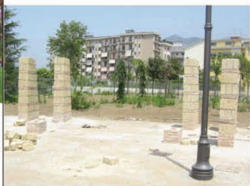
Fasi di realizzazione della pensilina in blocchi di tufo e struttura portante in legno
