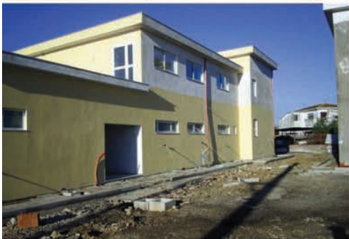
la stessa struttura a lavori conclusi
